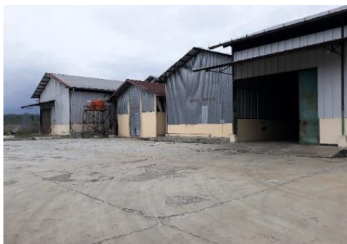
Gambar 1. Bangunan Perusda Puspahastama
