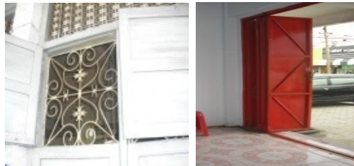
Gambar. Pintu, jendela dan ventilasi
