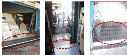
Gambar. Lantai teras yang telah dipasangi keramik (sampel 1 dan 2) Sumber: Hasil Survey, September 2010
