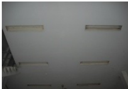
Gambar. Plafon dari tripleks (Sampel 1 mewakili delapan sampel lainnya) Sumber: Hasil survey,sept 2010
