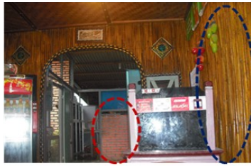
Gambar. Dinding pada sampel 10 Sumber: Hasil Survey, September 2010
