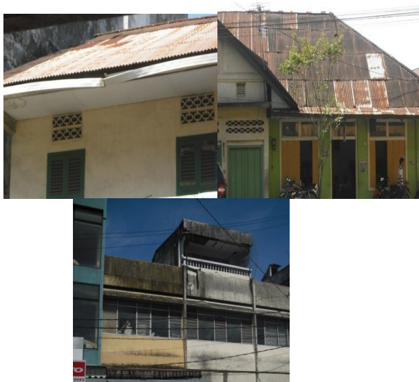
Gambar. Atap dari bahan seng dan beton Sumber : Hasil Survey, September 2010
