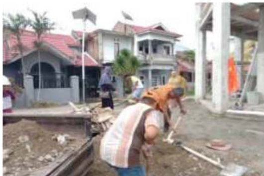
Gambar 3. Pendampingan Pelaksanaan Pengecoran Lantai Teras Masjid yang dilakukan Masyarakat dan Mahasiswa
