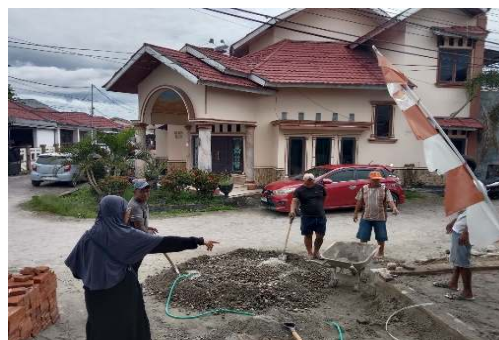
Gambar 2. Kontrol Pelaksanaan Pengadukan Campuran Beton untuk Pengecoran Lantai Teras Masjid
