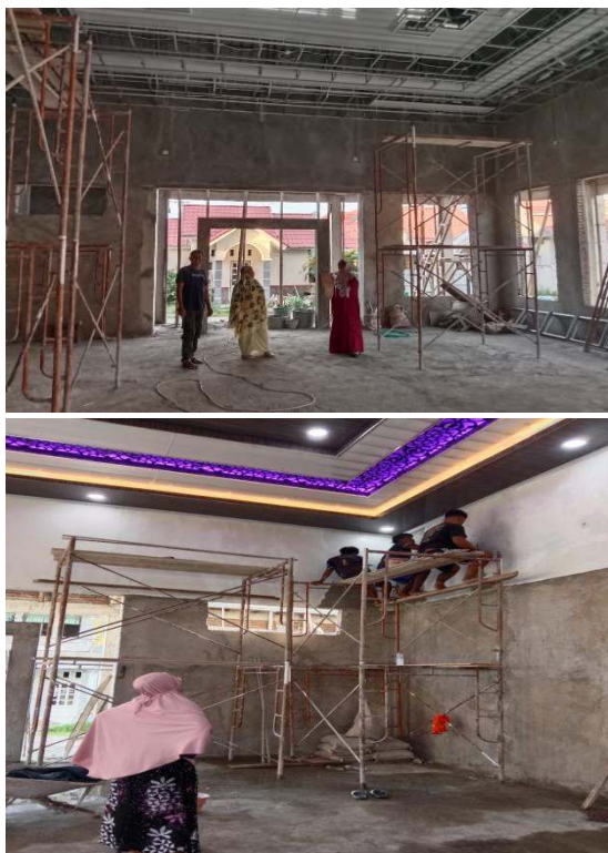
Gambar 1. Pemeriksaan Pemasangan Rangka Plafon, Panel PVC (atas) dan Pengecekan Hasil Akhir/Finishing (bawah)
