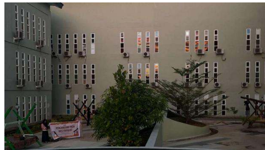
Gambar 10. Pemasangan empat unit gazebo di Taman Fakultas Teknik UNG (Sumber: Dokumentasi kegiatan, 2025)
