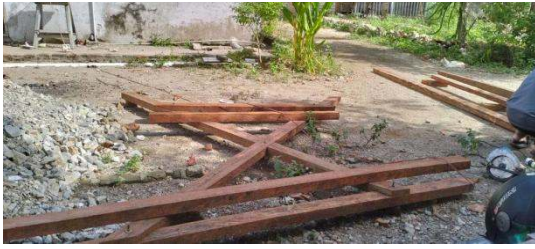
Gambar 3. Membuat rangka gazebo dengan sistem knockdown menggunakan baut (Sumber: Dokumentasi kegiatan, 2025)
