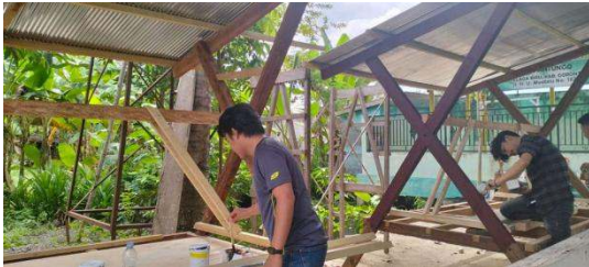
Gambar 6. Pengerjaan komponen gazebo (Sumber: Dokumentasi kegiatan, 2025)
