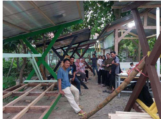
Gambar 7. Pengecatan gazebo (Sumber: Dokumentasi kegiatan, 2025)
