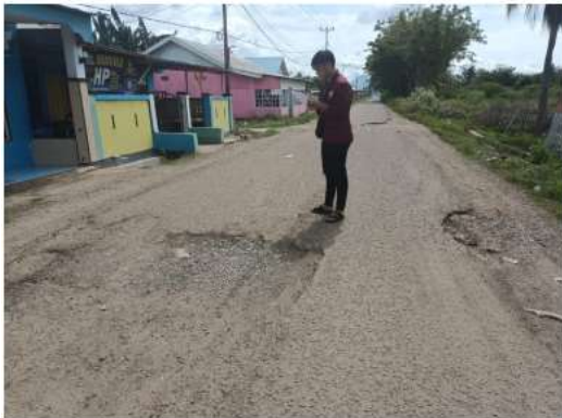
Gambar 1. Kondisi Jalan Rusak di Desa Bumi Bahari (Sumber: Data Primer, 2023)
