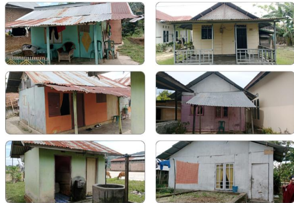
Gambar 5. Kondisi rumah tidak layak huni di Desa Dulohupa
