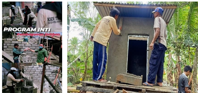
Gambar 3. Pembangunan WC Umum
