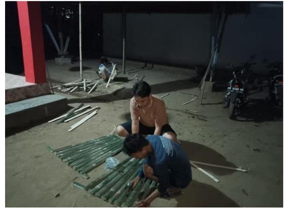
Gambar 3. Proses penyatuan rangka bambu
