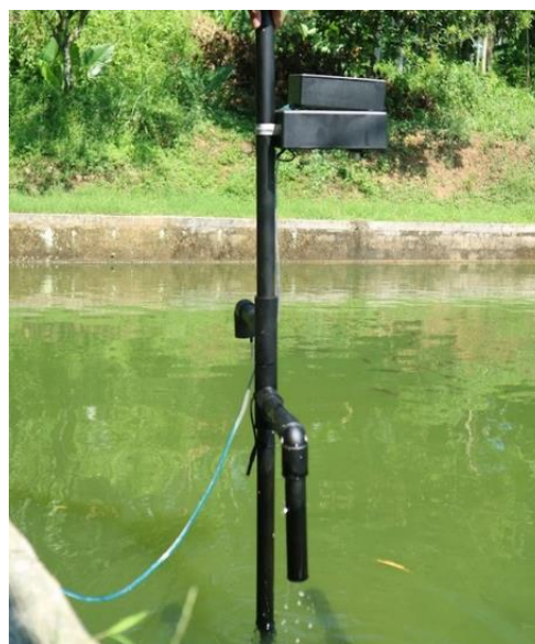
Gambar 9. Pemasangan Alat Sistem Monitoring Kualitas Air Berbasis IoT
