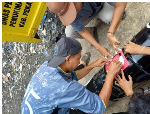
Gambar 2 . Proses Pemasangan Pintu dan Cerobong Asap
