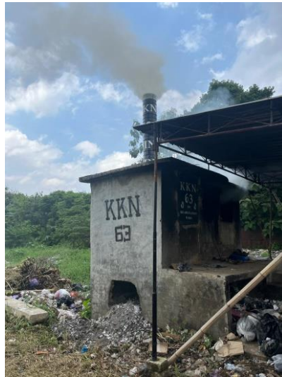
Gambar 3 . Tungku Pembakaran Sampah Setelah Pemasangan Pintu dan Cerobong asap
