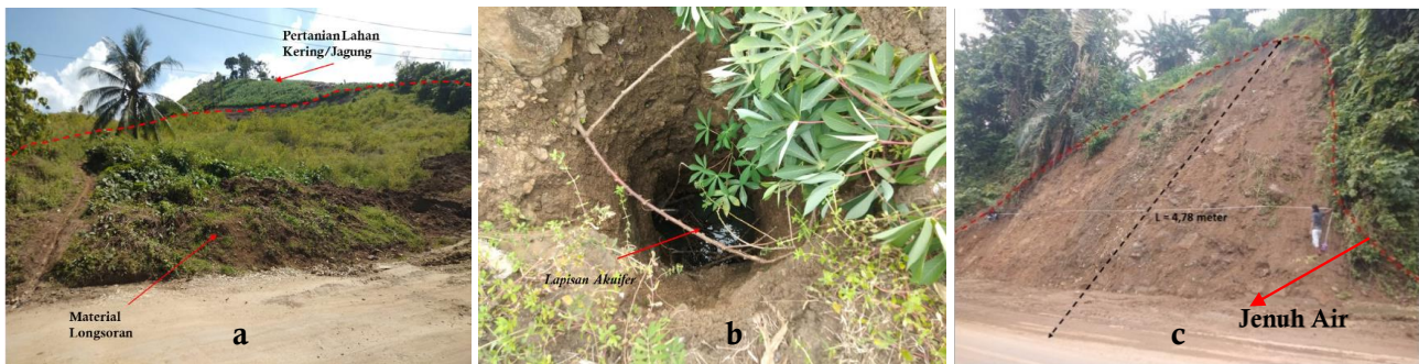
Gambar 8. Kejadian longsor berdasarkan faktor penyebab terjadinya longsor, (a) Longsor pada lahan pertanian jagung; (b) longsor di sekitar akuifer; (c) longsor pada tanah jenuh air
