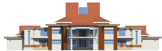
Gambar 14. Tampak Depan Gedung Kepegawaian (Sumber : Pribadi)
