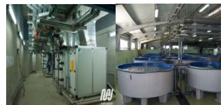
Gambar 9. Interior Pada Ruang Ruang Service (Sumber: Google Image, 2018)
