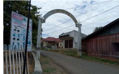
Gambar 2. Kondisi Gapura Selamat Datang (Sumber: Data Primer 2020)
