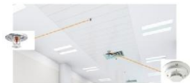
Gambar 17. Sprinkler dan Smoke Detector (Sumber: Hasil Analisa,2021)
