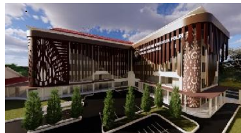
Gambar 2. Secondary Skin pada Fasad (Sumber: Analisis Penulis, 2021)
