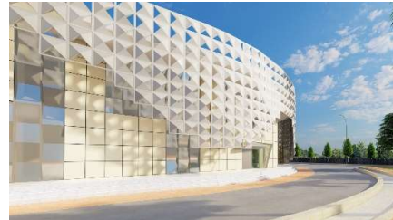
Gambar 3. Fasade bangunan ('Stainless Steel Cladding, Aluminium Composite Panel dan kaca Low-E) (Sumber: Analisis Penulis, 2023)
