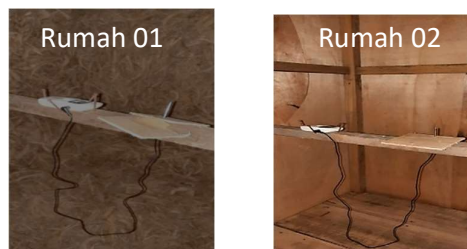
Gambar 3. Tampak Permukaan Dinding Bagian Dalam (Dokumentasi Pribadi, 2024)
