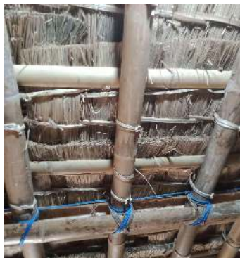
Gambar 5. Sambungan rangka atap (Sumber; dokumentasi pribadi, 4 Mei 2024)
