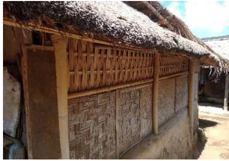
Gambar 2. Dinding bale tani yang terbuat dari anyaman bambu (Sumber; dokumentasi pribadi, 4 Mei 2024)
