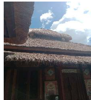
Gambar 15. Atap masjid dari material alang-alang (Sumber; dokumentasi pribadi, 4 Mei 2024)
