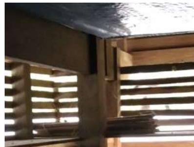
Gambar 15 : Sambungan ringbalk (pattolo yase') dengan kolom dinding (alliri renring)
