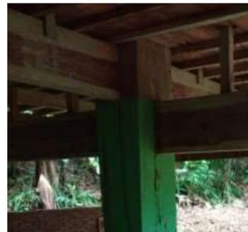
Gambar 12. Sambungan antara kolom dan balok (pattolo yawa)
