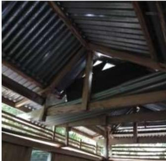
Gambar 16 : Sambungan antara rangka -kuda dengan ringbalk kayu (*pattolo yase*)
