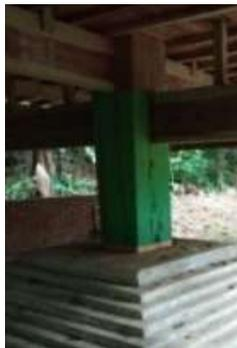
Gambar 11. Sambungan antara pondasi dan kolom (alliri)
