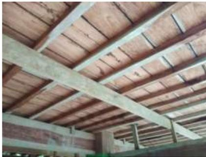
Gambar 13. Sambungan balok (pattolo yawa) dengan balok lantai (tunebbe batapola)
