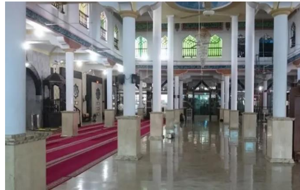
Gambar 3. Void Pada Bagian Tengah (Sumber: Pribadi, 2025)
