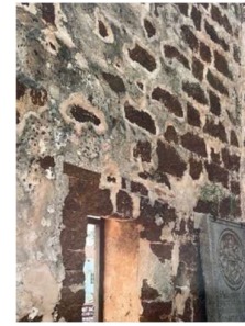
Gambar 6. Konstruksi dinding pada Benteng Famosa (sumber: Dokumentasi Penelitian, 2025)
