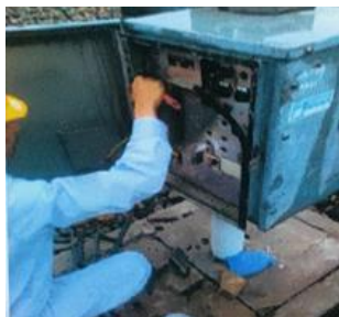
Gambar 3. Pergantian door sealent
