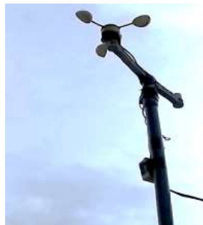
Gambar 3. Pemasangan AWS pada tiang besi
