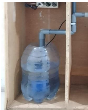
Gambar 12. Pemasangan Pompa Air
