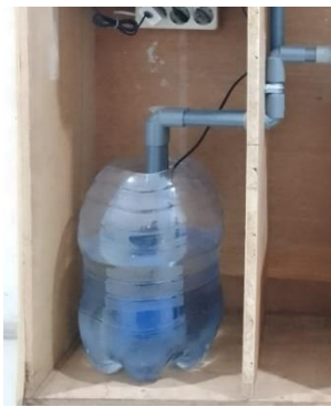
Gambar 12. Pemasangan Pompa Air
