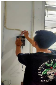
Gambar 18. Pemasangan Panel Sistem Kendali Lampu Berbasis IoT Arduino Cloud
