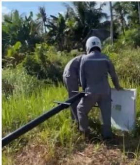
Gambar 14. Proses Pemasangan Sistem Panel Surya LPJU
