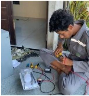
Gambar 13. Instalasi sensor kepanel box lampu jalan
