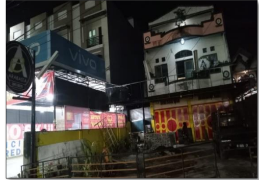
Gambar 5. Café yang sedang renovasi (sumber: Dokumentasi pribadi )
