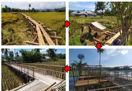
Gambar 3: Proses perwujudan jembatan (Sumber: Dokumentasi peneliti, 2021)
