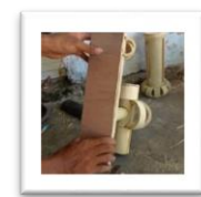
Gambar 11: Proses memasang tripleks pada bagian belakang kap lampu (Sumber : Foto peneliti, 2023)
