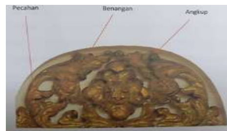
Gambar 4. Detail Ornamen pada ventilasi
