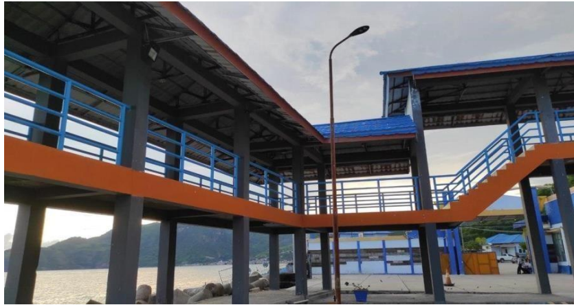
Gambar 8. Gangway di Pelabuhan Penyeberangan Gorontalo
