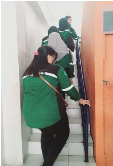
Gambar 1. Kondisi Tangga disekolah
