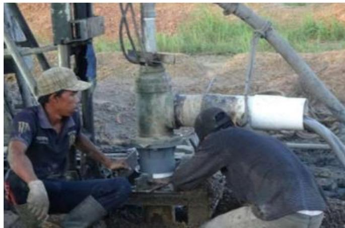
**Gambar 2. Pemantauan Pemboran untuk Menentukan Kedalaman Akuifer**
