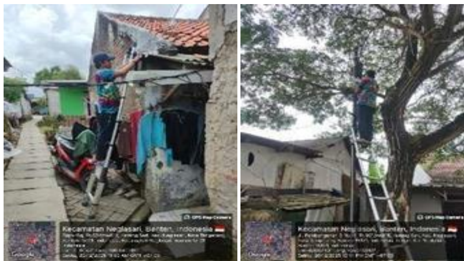
Gambar 1. Pemasangan jaringan serat optik di rumah perwakilan anggota KSPM
