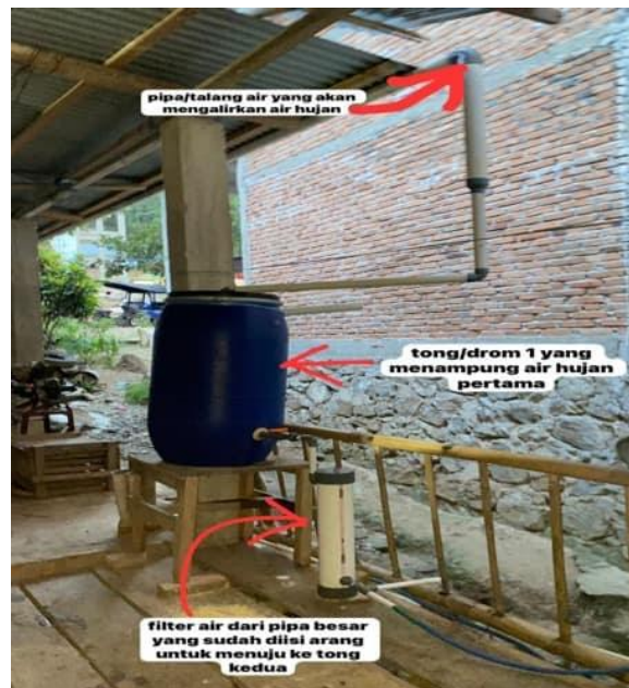
Gambar 3. Alat Penampung Air Hujan (APAH)
