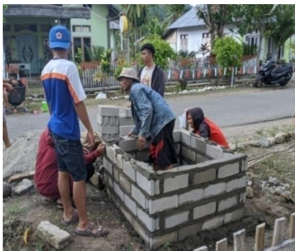
Gambar 4. Pelaksanaan Pembangunan Bak Sampah
