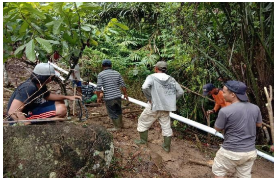
Gambar 3. Pemasangan Pipa Penstock
