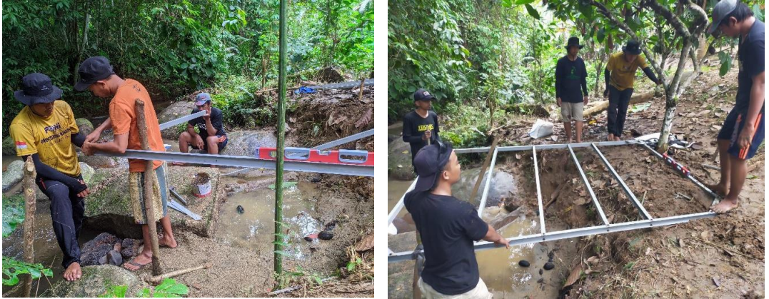
Gambar 4. Perakitan rangka atau Rumah Pembangkit
