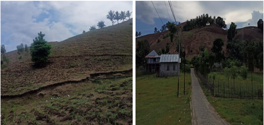
Gambar 1 Kondisi Desa Langge
