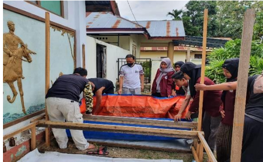
Gambar 2. Membuat kolam dari terpal.
