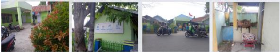
Gambar 9. Eksisting Condition Kantor Kelurahan Dulomo Utara
