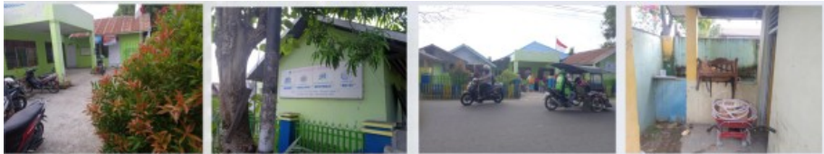
Gambar 9. Eksisting Condition Kantor Kelurahan Dulomo Utara
